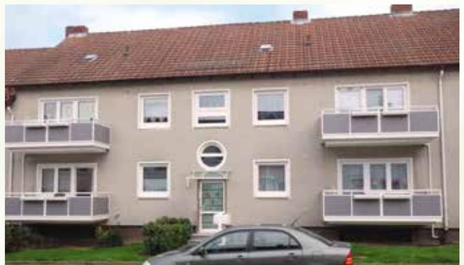
*Mithilfe eines Krans wurden die Aufschiebbalkone in der Stettiner Straße in Goslar in Position gebracht und an der Außenwand montiert. Das Ergebnis kann sich sehen lassen.*
